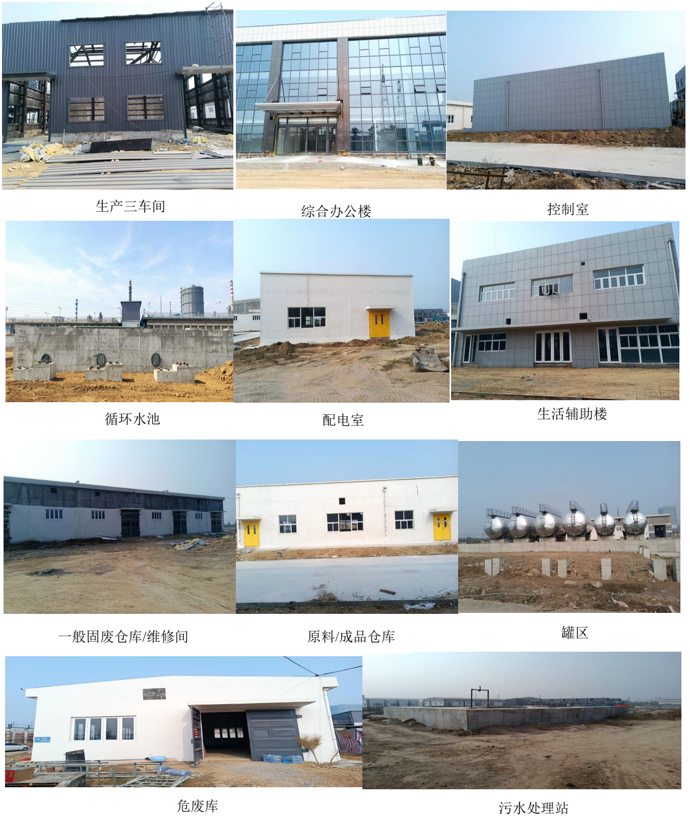
图 3.2-1 厂区建设现状图
