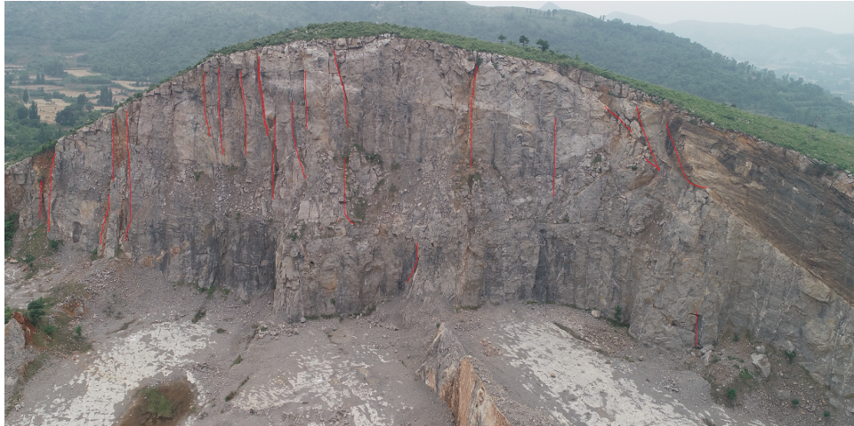
图 3-7 治理区岩面裂隙现状照片
