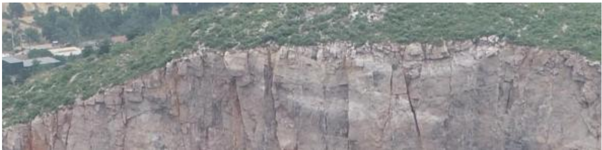
照片 3-6 治理区采坑坡顶现状照片
