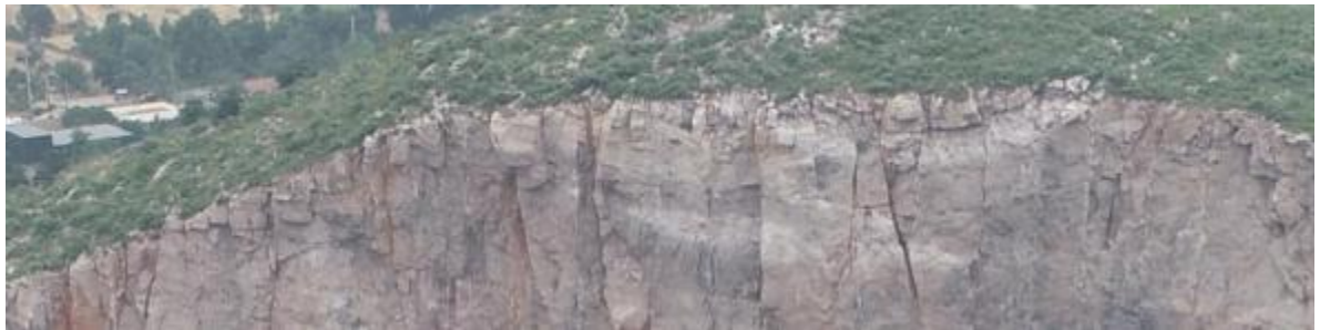
照片 2-8 治理区采坑坡顶现状照片
