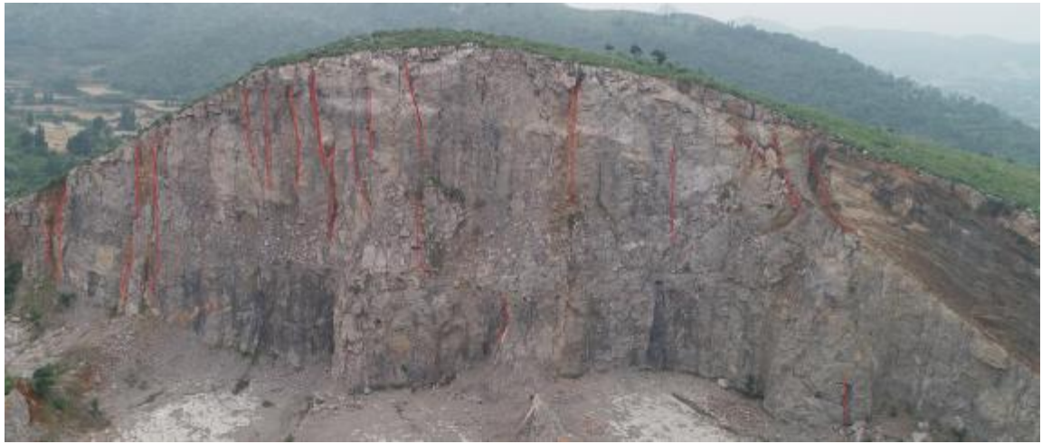
照片 2-9 治理区岩面裂隙现状照片
