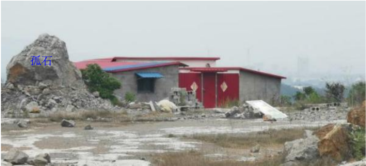
照片 3-4 采石坑房屋建筑现状照片
