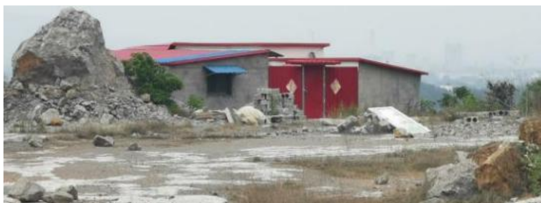
照片 2-7 采石坑房屋建筑现状照片
