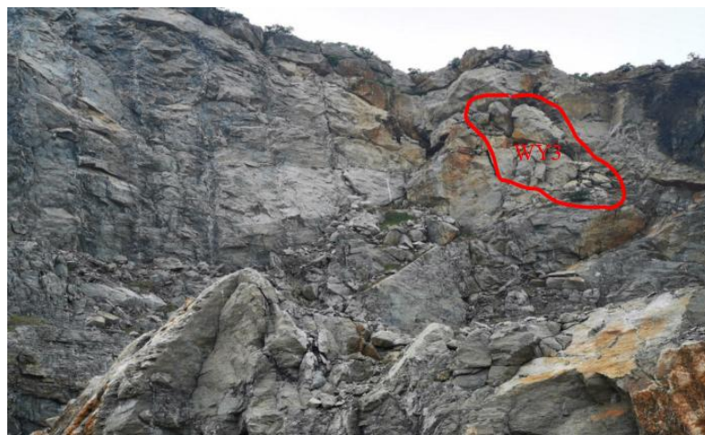
图 3-5 治理区采坑危岩体现状照片
