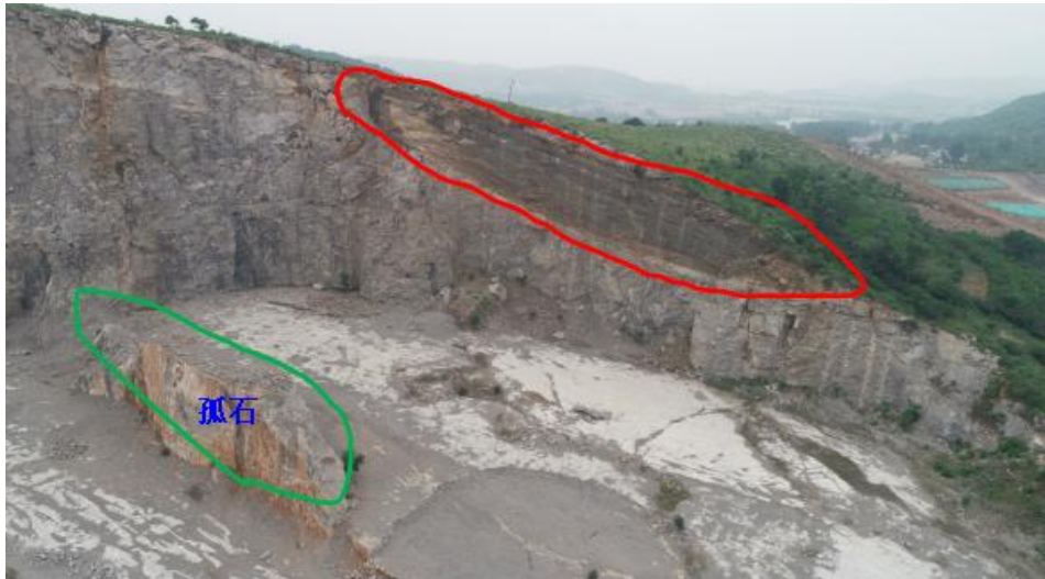
图 3-4 采石坑独立孤石、页岩岩层现状照片
