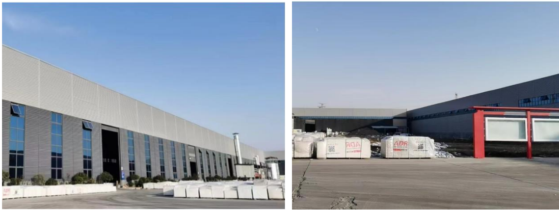
图 2-6 改扩建项目现状照片
