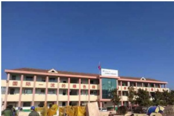
升压站站内综合楼
