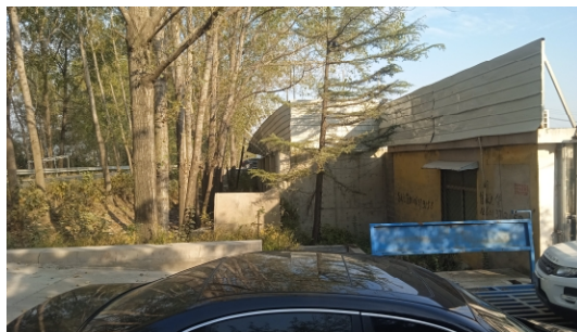
厂区北侧大门外东侧
