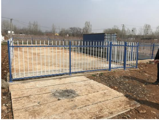
前台村移民安置区污水处理系统
