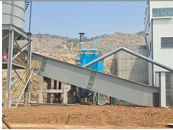
附图 9 项目现场勘察图
