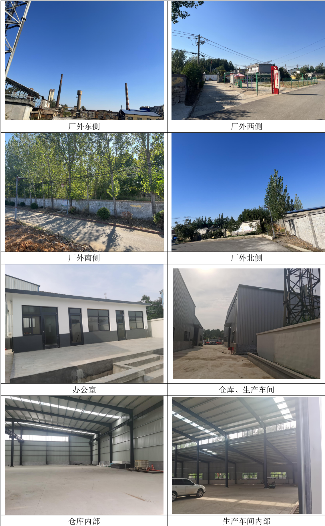
附图 3 项目现场踏勘现状图
