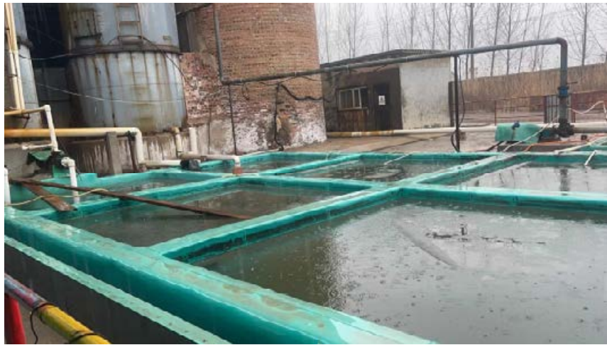
碱液脱硫池（分有六个水池，分别对应双碱法脱硫的再生池、沉淀池和循环池）
