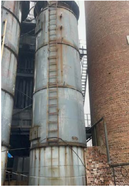
原有脱硫副塔已废弃，启用并改造为重力喷雾洗涤器以及内部结构
