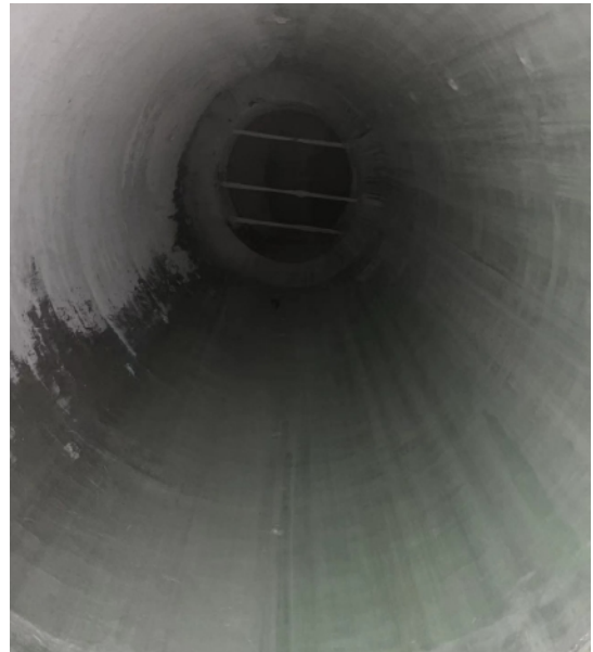
原有脱硫副塔已废弃，启用并改造为重力喷雾洗涤器以及内部结构
