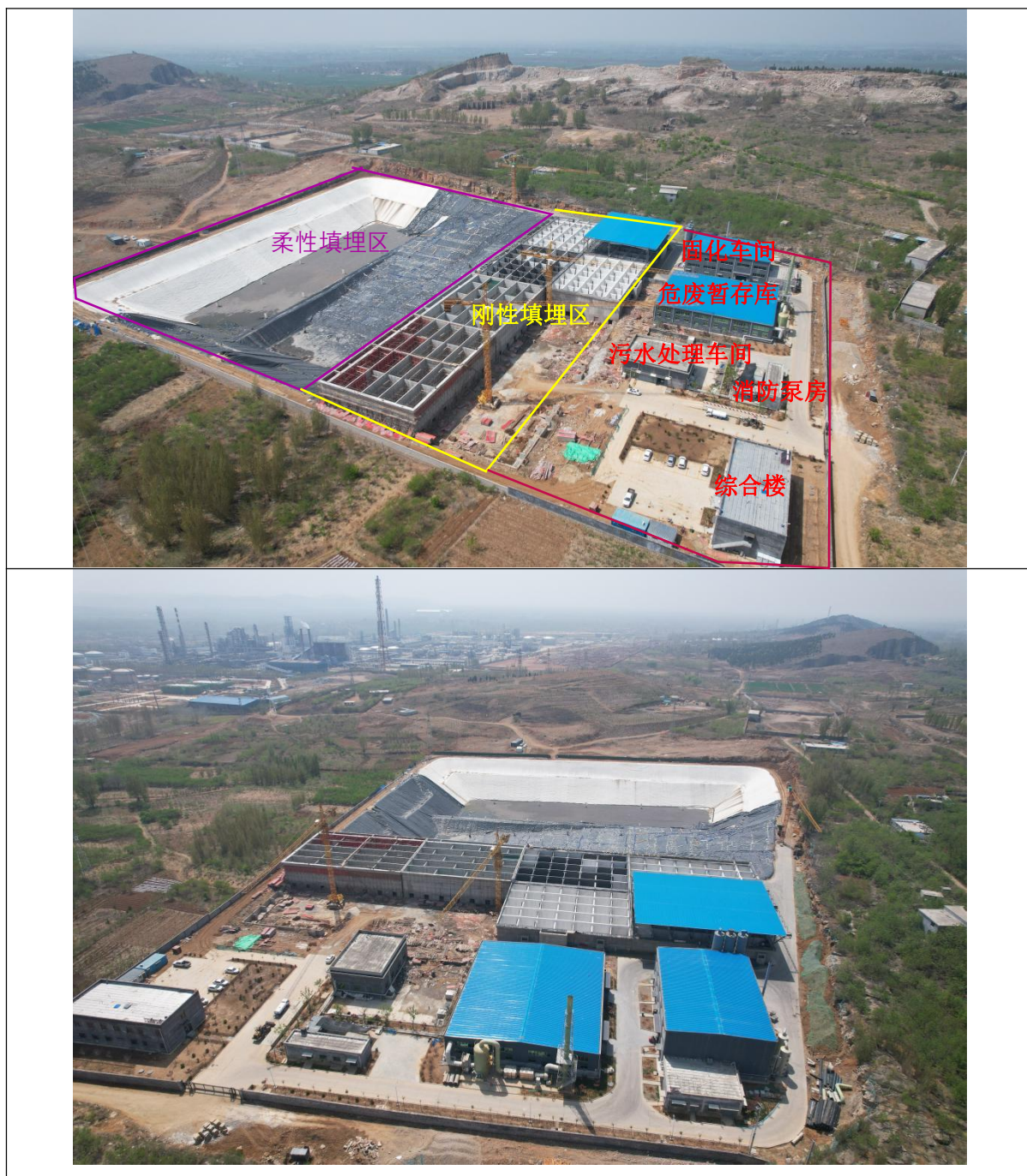
现有工程现场照片
