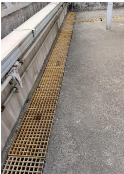
罐区围堰及导流渠
