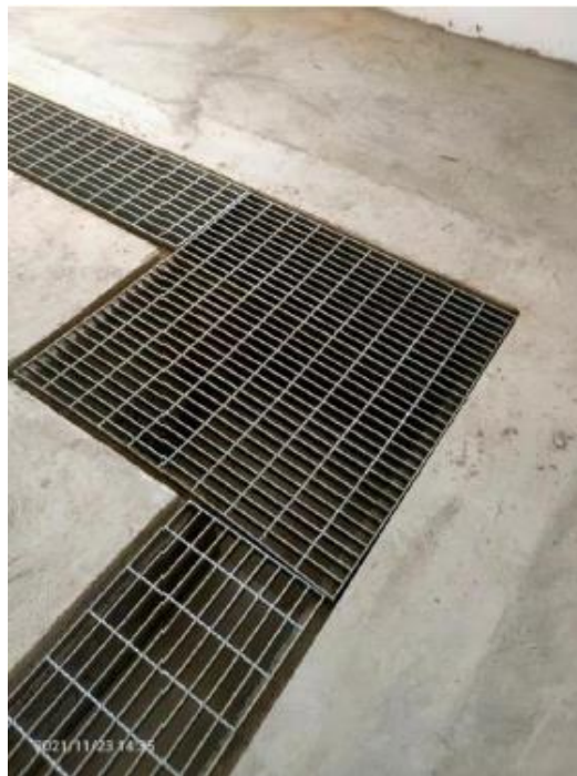
装置区导流渠及废水收集池
