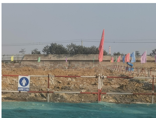
站址拟建区域
