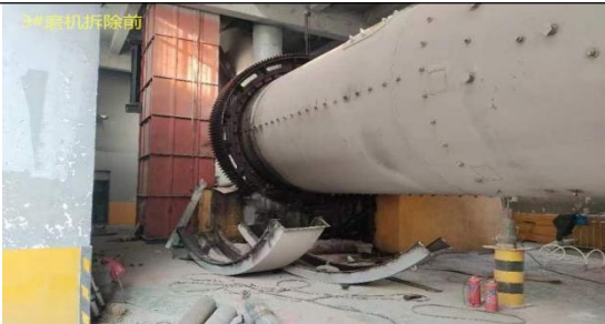
滕州市东郭水泥有限公司原有水泥粉磨机拆除前后照片
