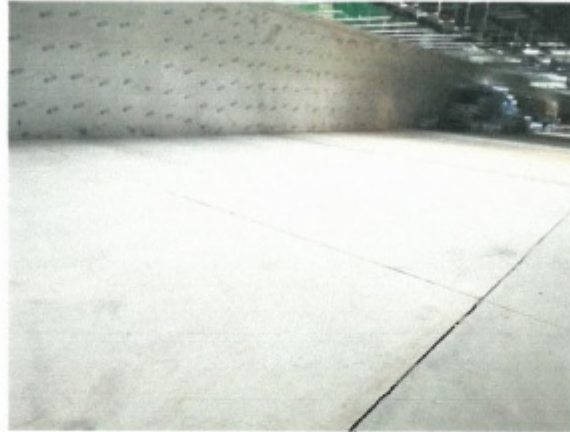
项目现场照片
