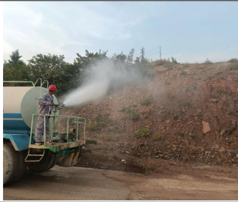
矿区设置洒水车及洗车平台
