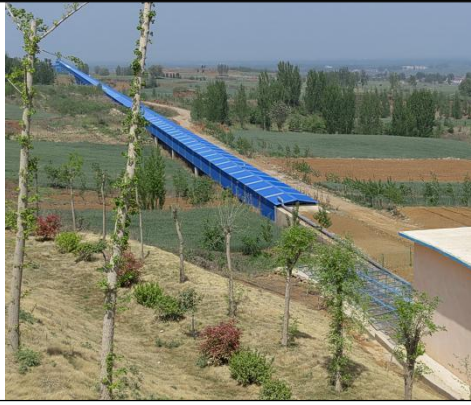
石灰石由封闭皮带廊道运输进厂
