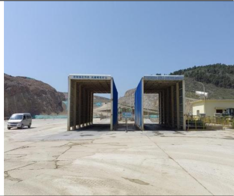
矿区设置洒水车及洗车平台
