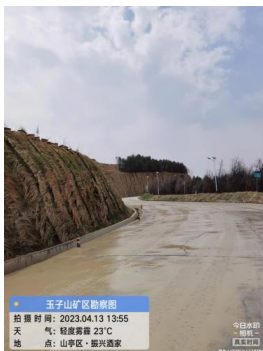
道路喷淋装置
