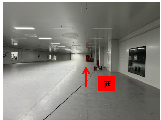
3#拟建辐射屏蔽室西侧区域现状
