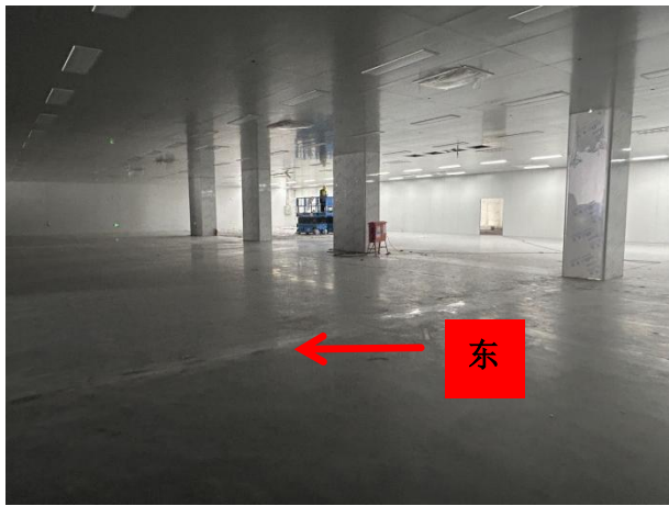
4#拟建辐射屏蔽室东侧区域现状
