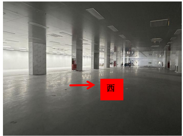
4#拟建辐射屏蔽室西侧区域现状
