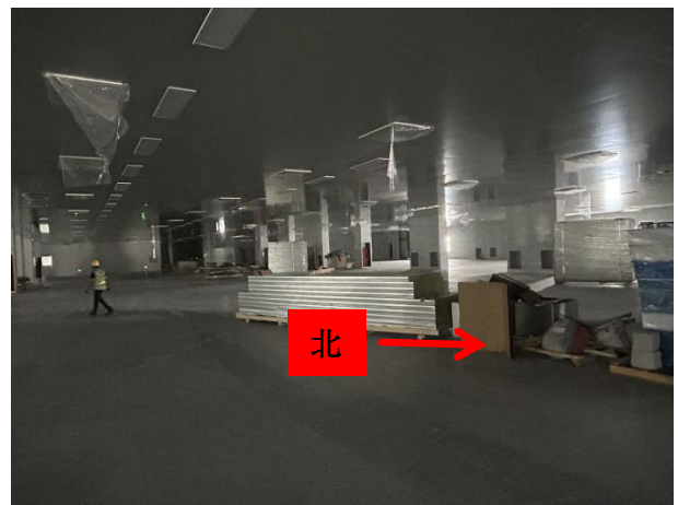
4#拟建辐射屏蔽室北侧区域现状
