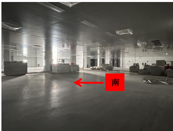
4#拟建辐射屏蔽室南侧区域现状
