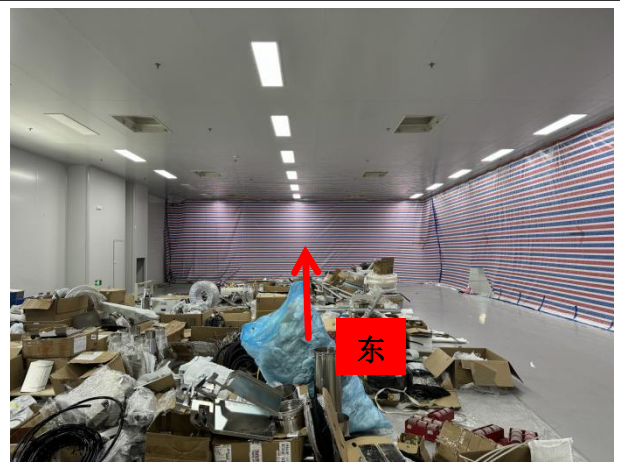
5#拟建辐射屏蔽室东侧区域现状
