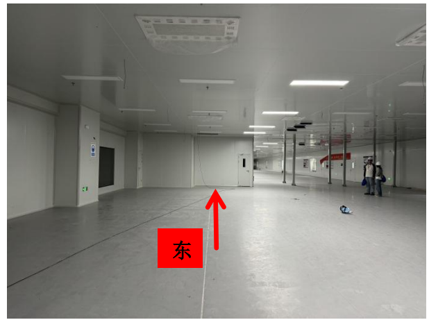
3#拟建辐射屏蔽室东侧区域现状
