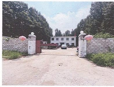
照片 7 奚村西北侧拟建双回架空线路线 西 23m 处民房
