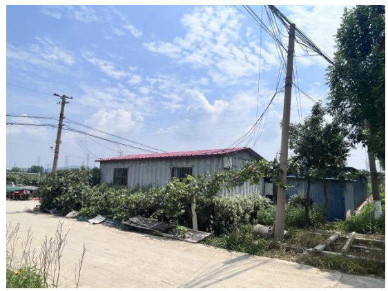
照片 10 奚村东南侧拟建双回架空线路南 28m 处农庄看护房
