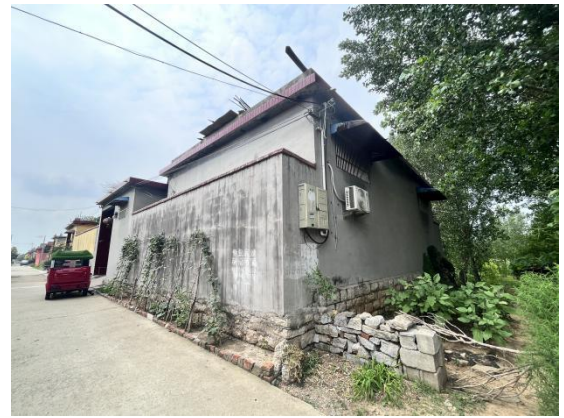
照片 4 簸箕掌村西北侧拟建双回架空线路东 26m 处一排民房
