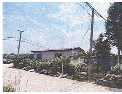
照片 10 奚村东南侧拟建双回架空线路 线南 28m 处农庄看护房
