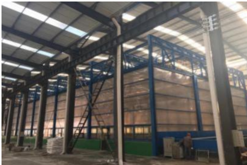
图 6.1-1 同类企业封闭酸洗房实景图
