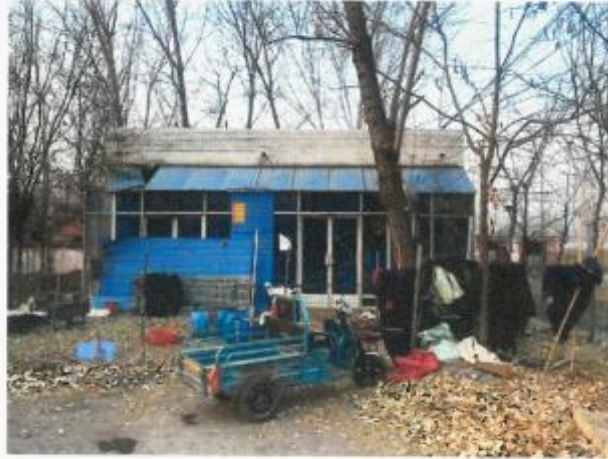
项目现场照片
