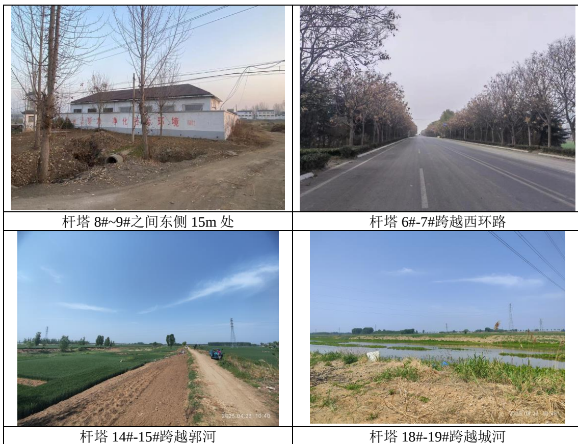
附图 12 本项目升压站及输电线路现状图
