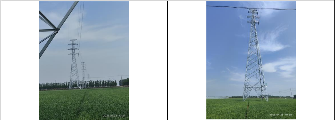
输电线路现状照片
