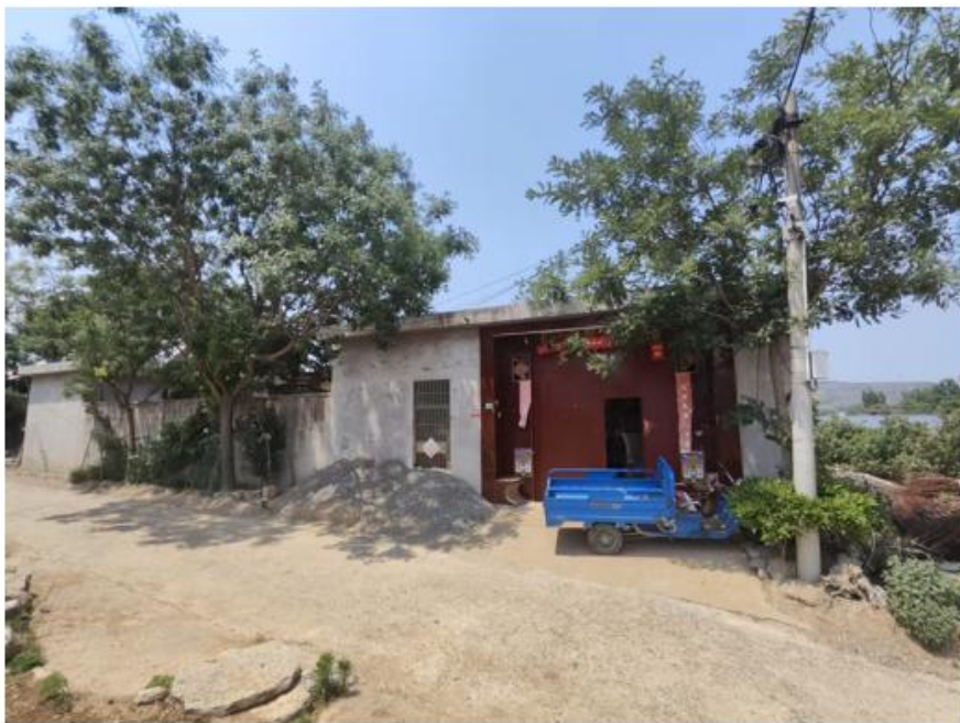
站址西侧4m王庄村民房
