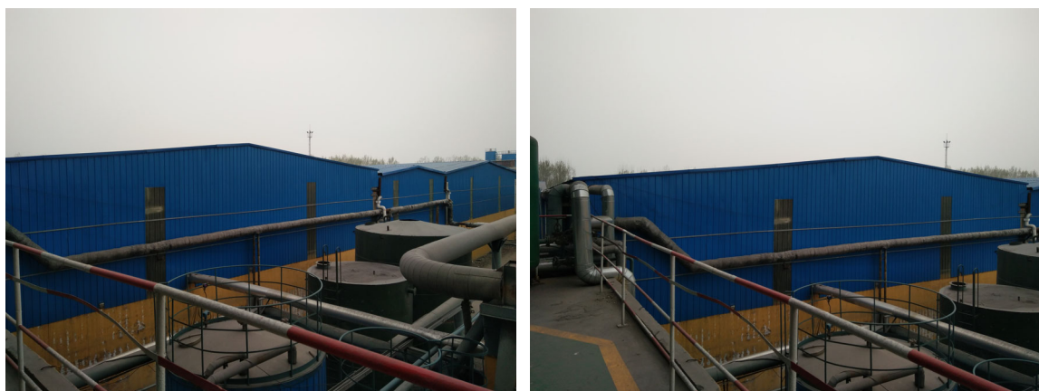
图2.2-3 燃料储存设施（全封闭设置）
