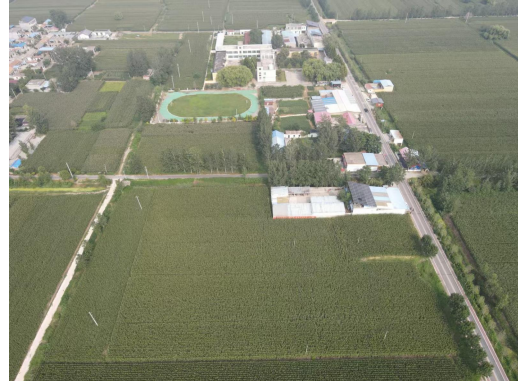
升压站站址以南
