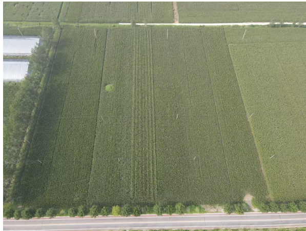
升压站站址（俯视图）
