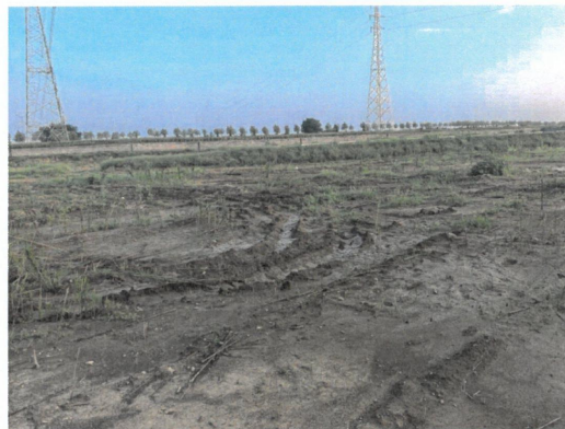
项目现场照片
