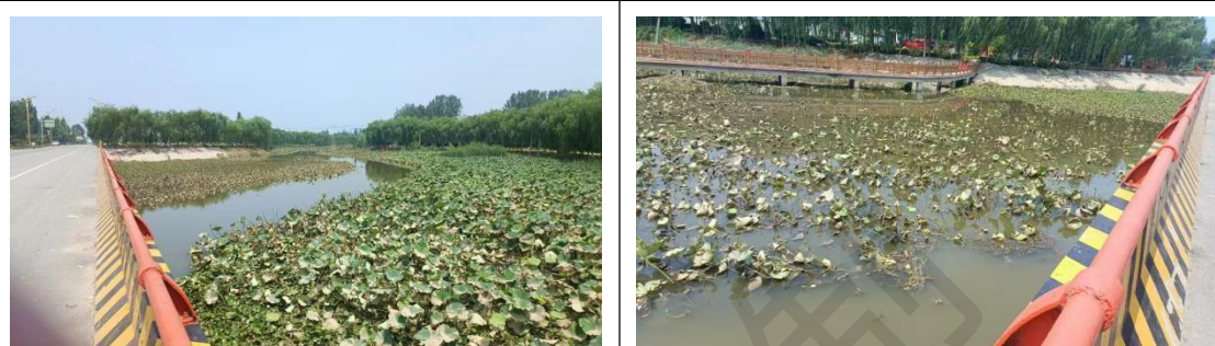
图 3.2-1 纳污河流小魏（沂）河人工湿地工程
