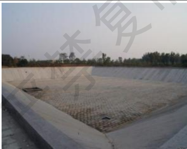
污水处理厂厂区内现有 24000m 3 事故水池
