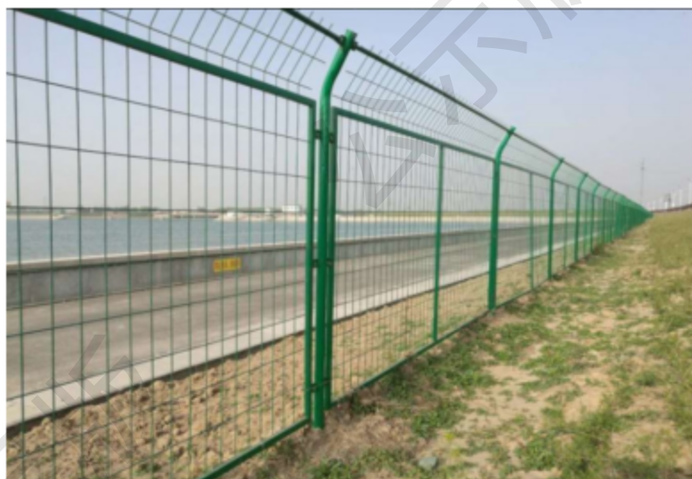
图 2.4-27 饮用水水源保护区隔离防护设施示意图
