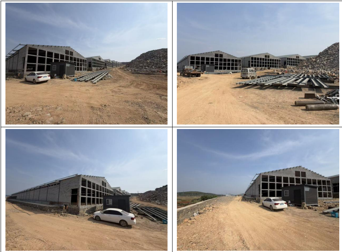
图 2.1-6 拟建项目建设现状图
