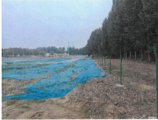
项目现场照片
