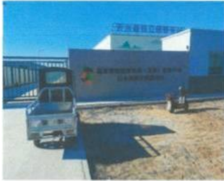
项目现场照片
