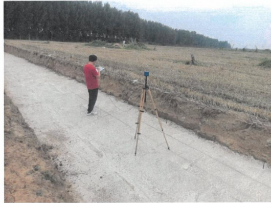
现场检测照片
