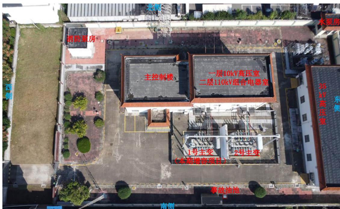
图 2-1 变电站现状俯视照片
