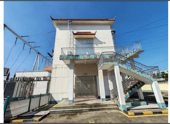
1层 10kV 高压室、2层 110kV 组合电器室
