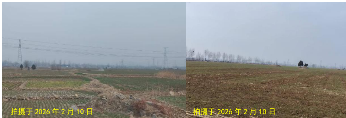
项目需要穿越的 220kV 衡文线照片
