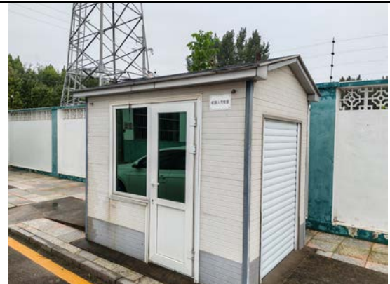
机器人充电室
