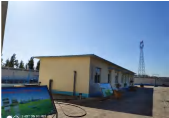
福兴煤矿北区污水处理厂
