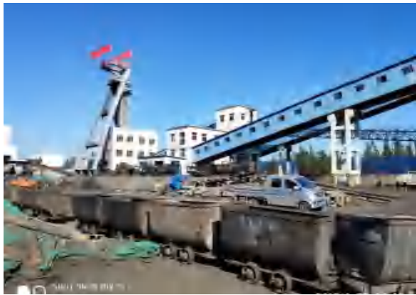
福兴煤矿北区主井
