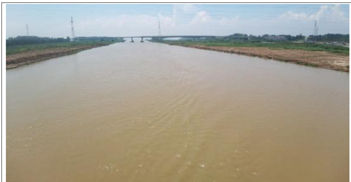
图 2.2-3 城郭河 S104 桥位置现状
