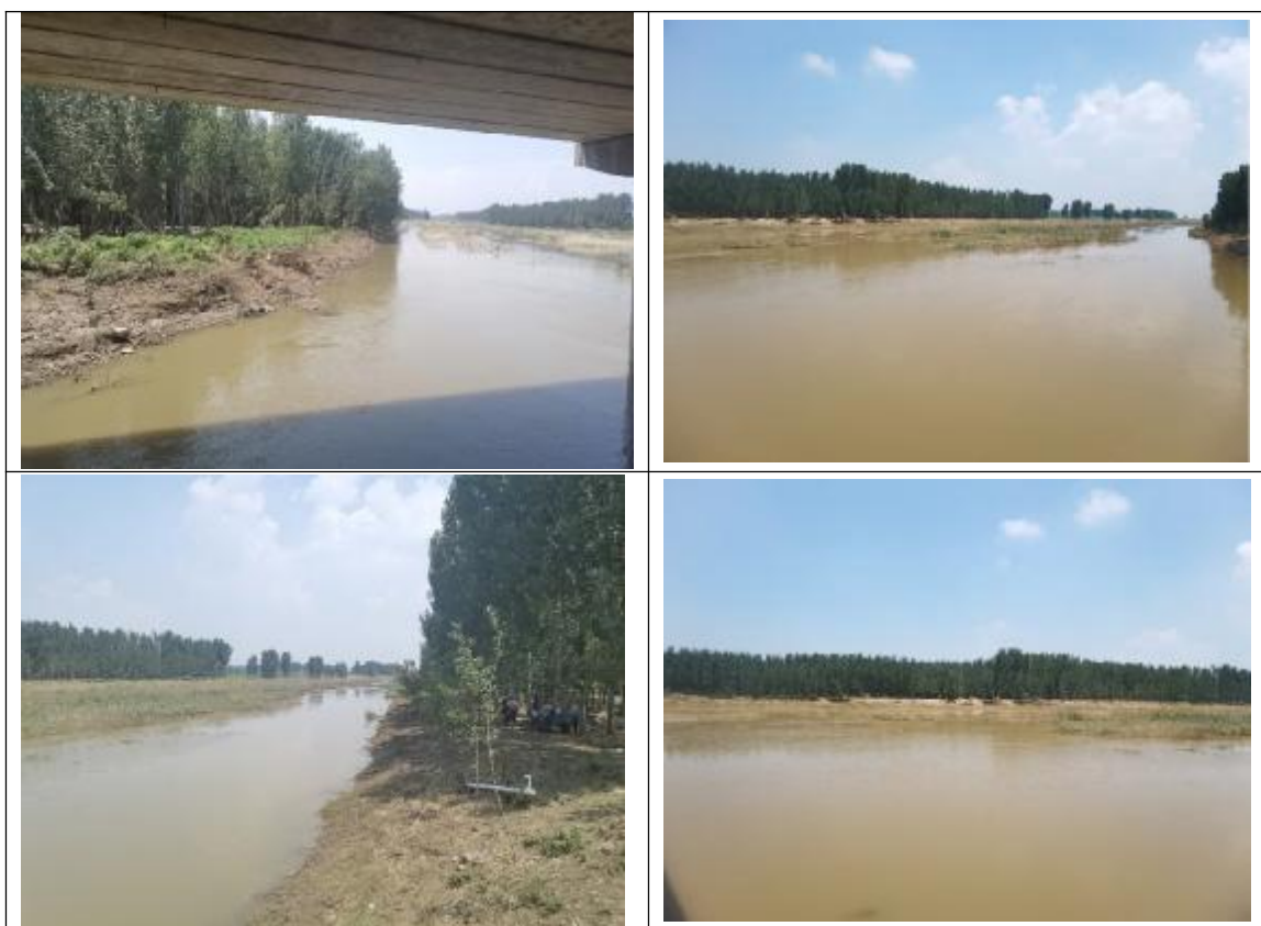
图 2.2-2 城郭河 S313 桥位置现状
