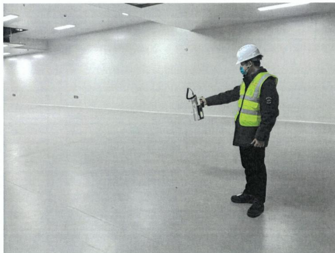
现场检测照片
