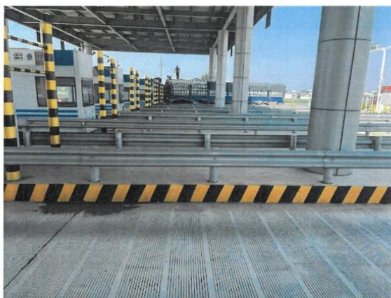
项目现场照片
