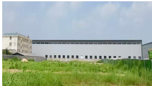
山东锦瑞重工有限公司车间
