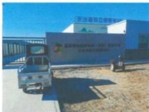
项目现场照片
