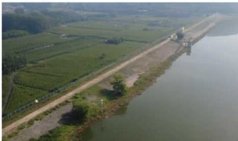
图 2.4-1 龙泉庄水库大坝及坝顶道路现状图
