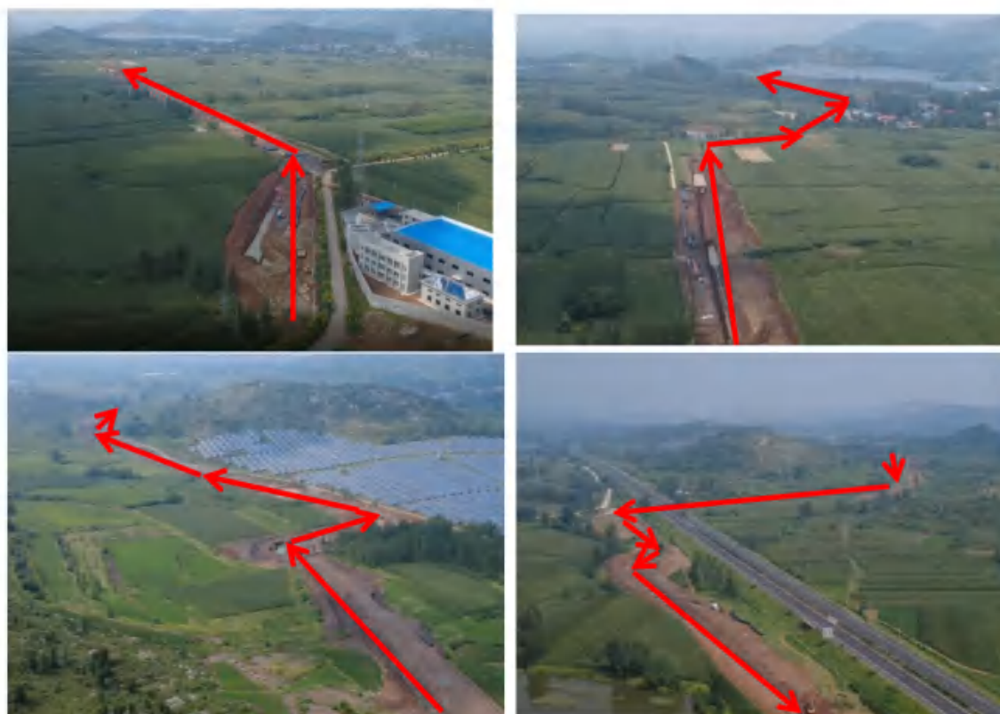
图 2.4-10 本项目管道路由现状情况图
