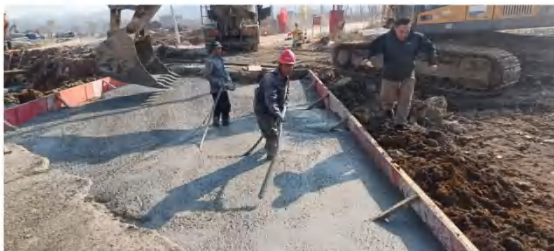
图 2.4-31 泵站混凝土工程施工现场图
