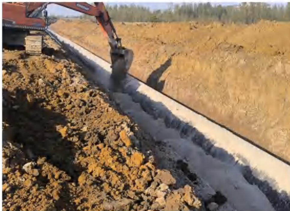
图 2.4-40 土方回填施工现场图（临时堆土）
