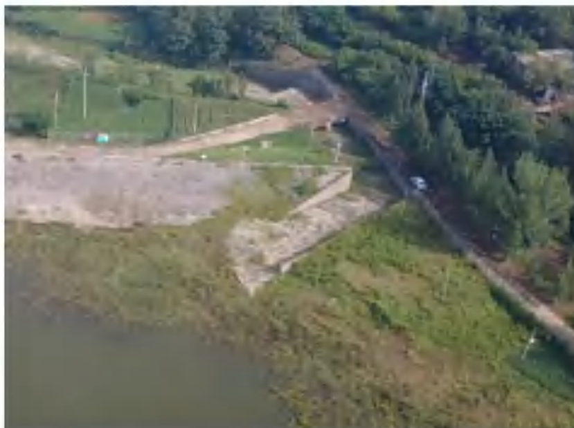
图 2.4-3 龙泉庄水库溢洪道现状图
