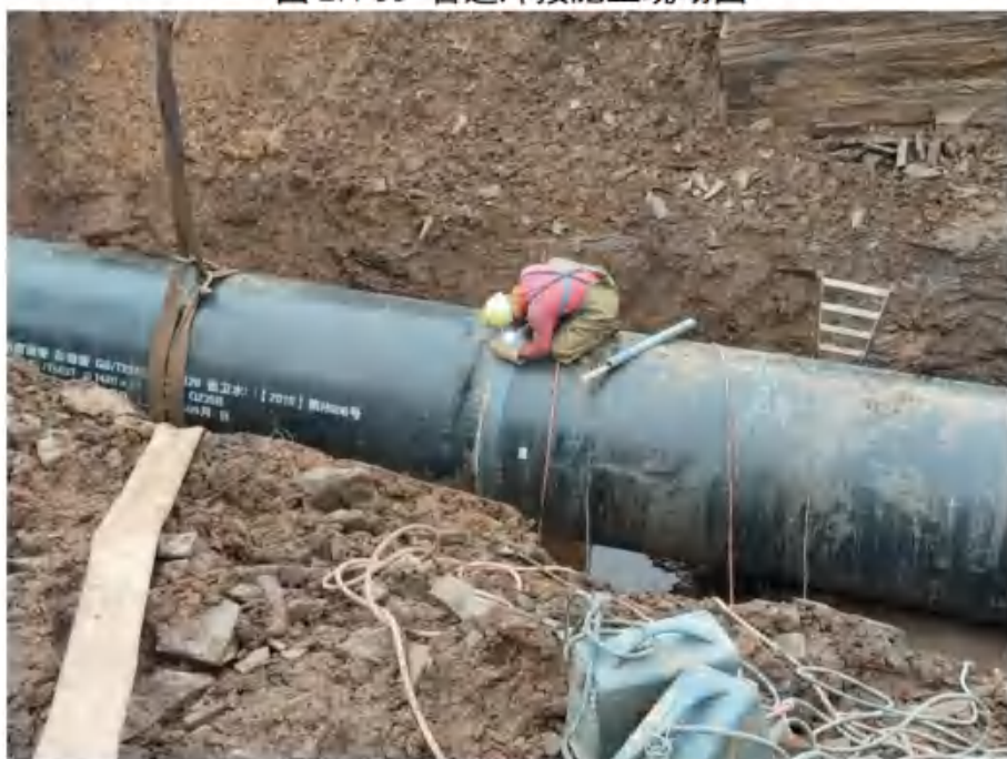
图 2.4-36 管道外连接涂层修补施工现场图
