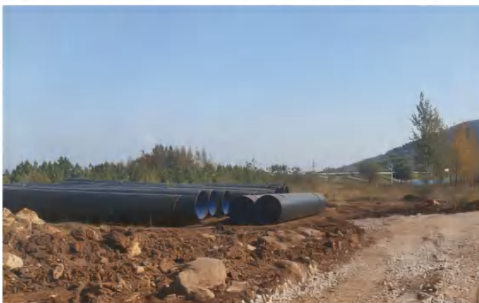
图 2.4-33 管道堆放现场图
