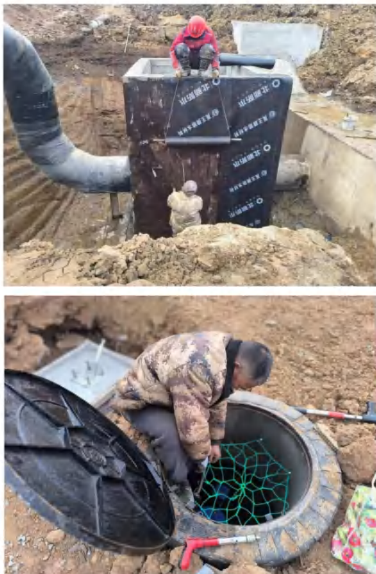
图 2.4-41 阀门、阀井施工现场图
