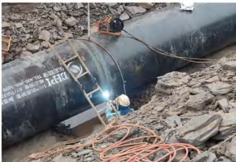
图 2.4-35 管道焊接施工现场图
