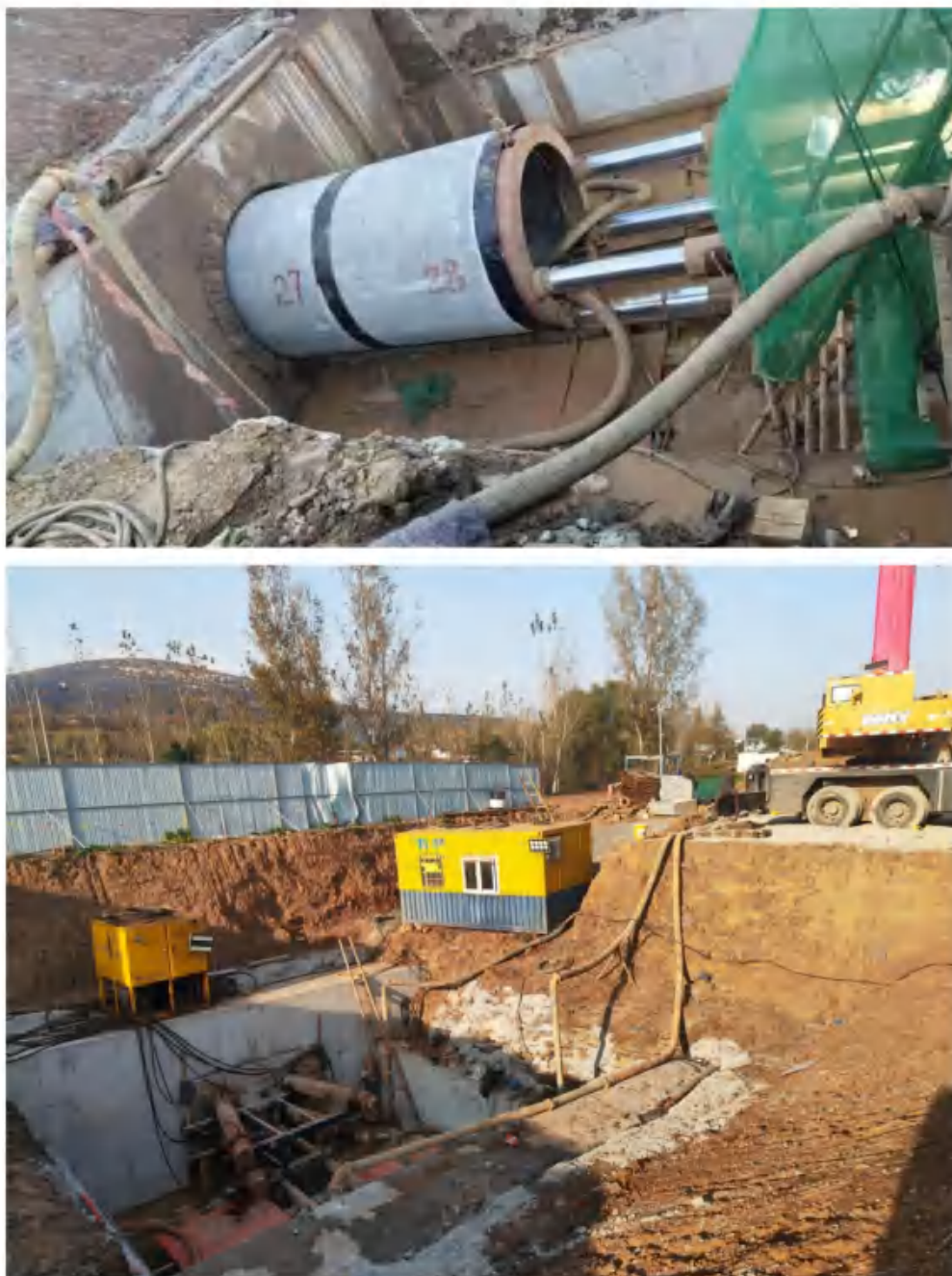
图 2.4-39 顶管穿越施工现场图
