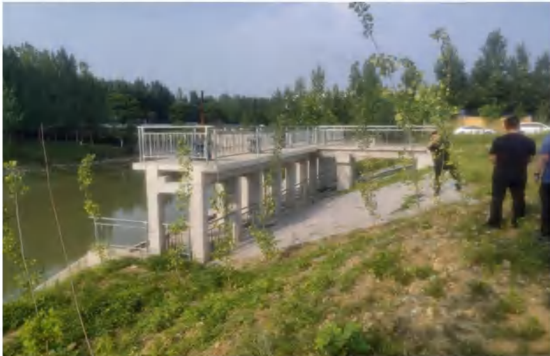
图 2.4-4（1）胜利渠渠首（峰城区）取水口实景照片
