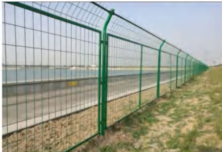
图 2.4-26 饮用水水源保护区隔离防护设施示意图
