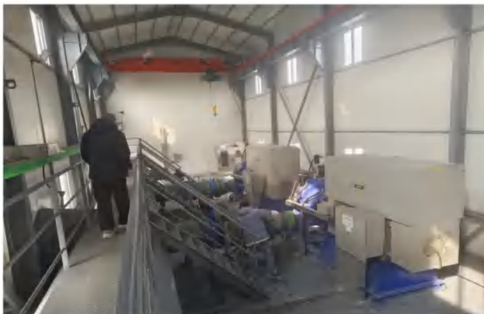
图 2.4-44 泵站设备安装现场图
