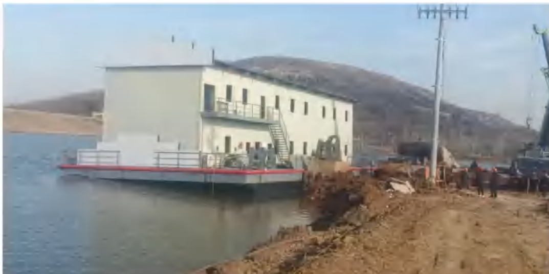
图 2.4-45 浮船泵站建设情况图
