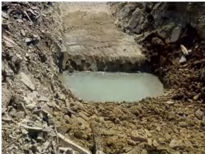
图 2.7-3 施工期基坑废水处置措施情况图
