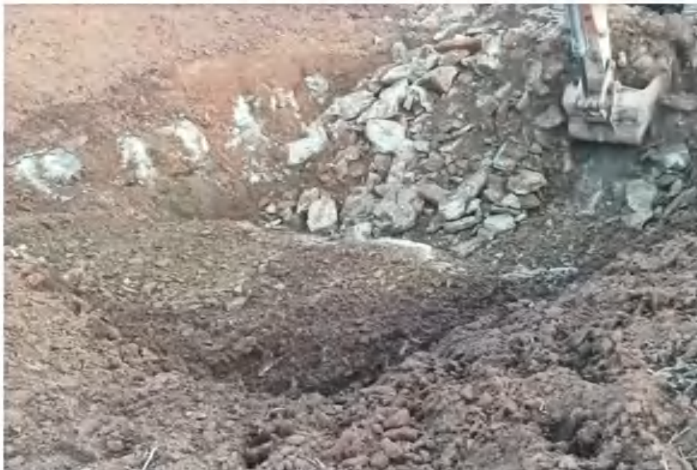
图 2.4-38 顶管工作井开挖现场图
