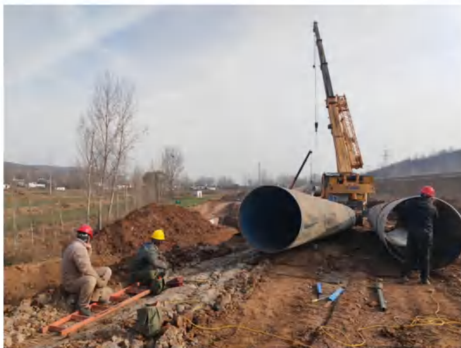
图 2.4-32 管道吊装现场图
