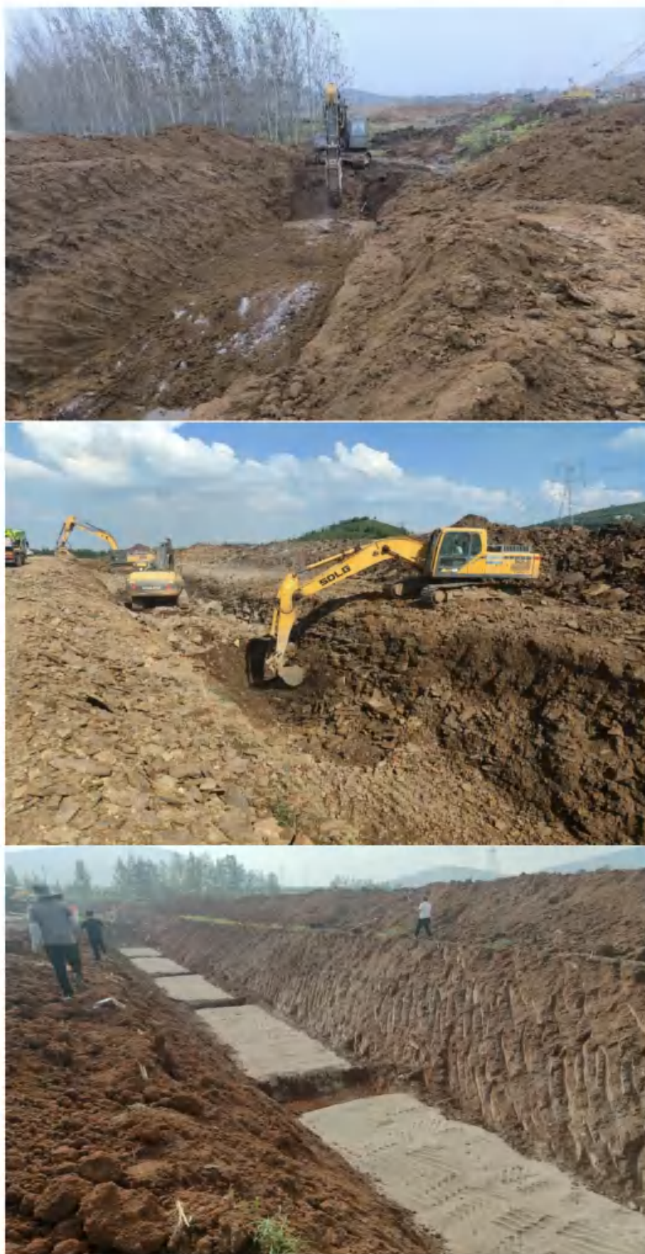
图 2.4-34 土方开挖及沟底平整施工现场图
