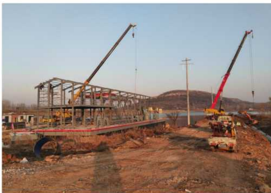
图 2.4-43 泵站施工现场图
