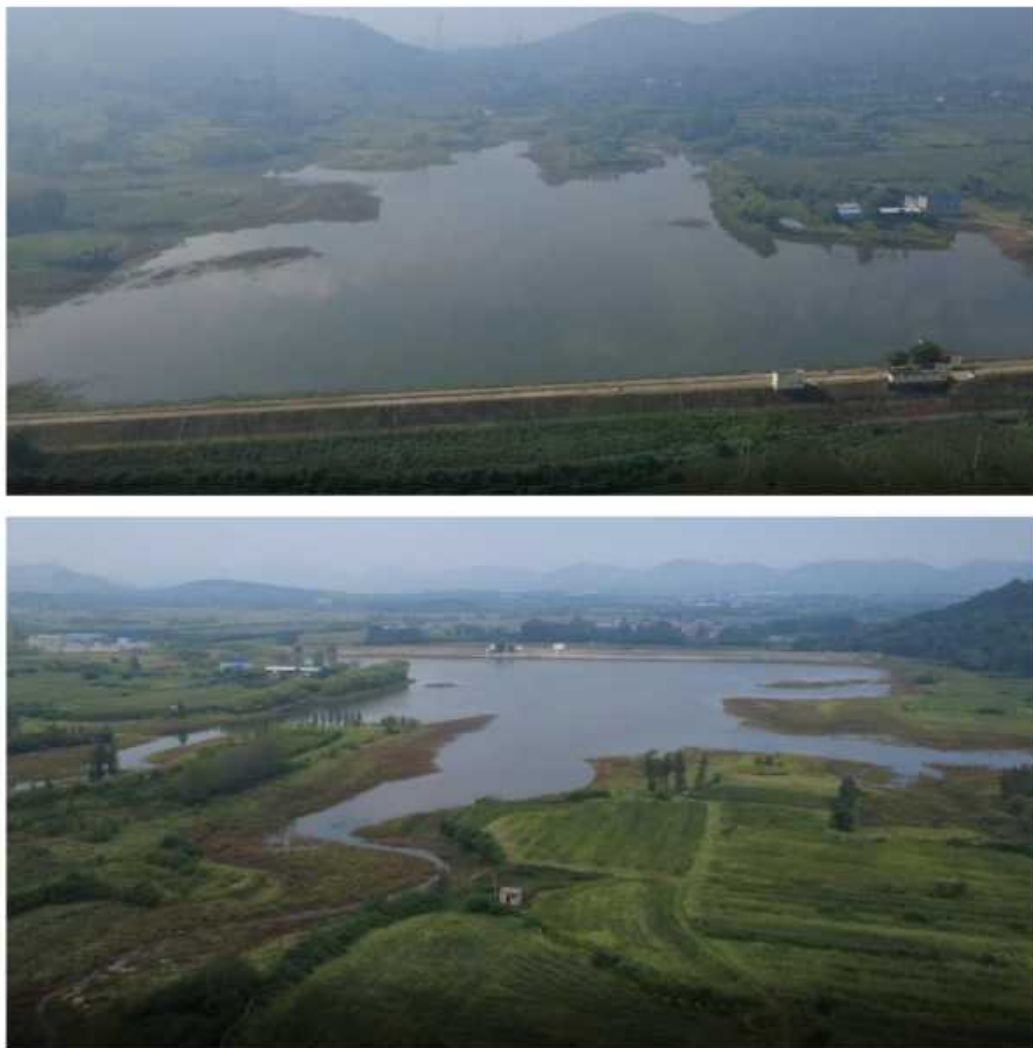
图 2.4-6 本项目水库现状情况图
