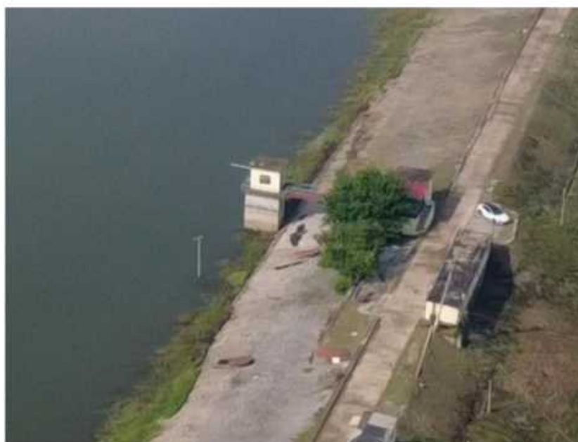
图 2.4-2 龙泉庄水库放水洞现状图
