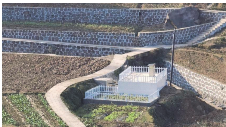
图 1-5 南江县天关村“户用小三格式化粪池+厌氧滤池+贮存池+资源化利用”应用实景图
