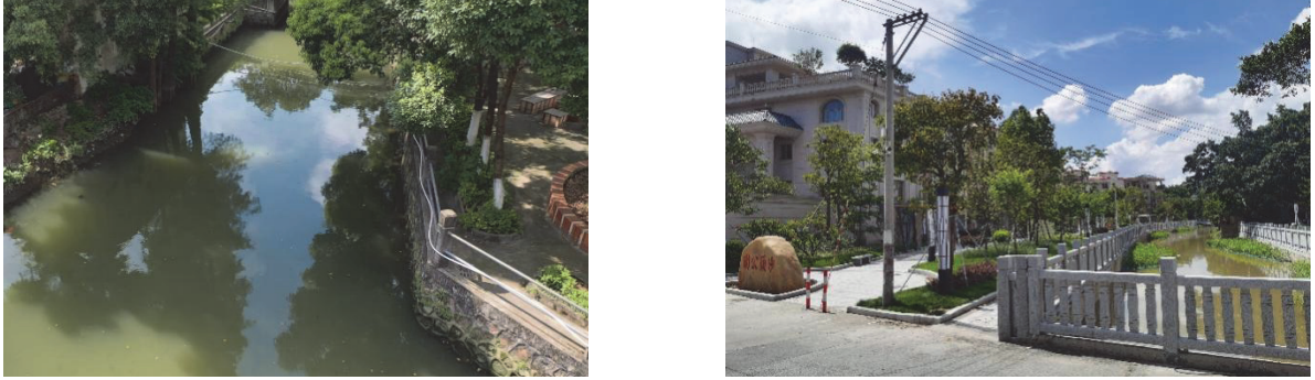
图 2-2 三茄涌(沙头)整治完成实景图
