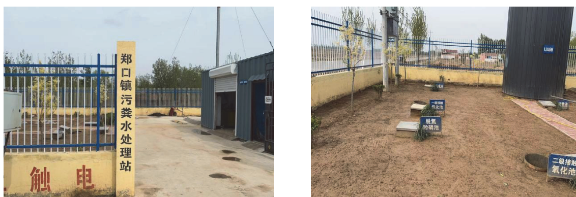
图 5-3 集中处理站实景图
