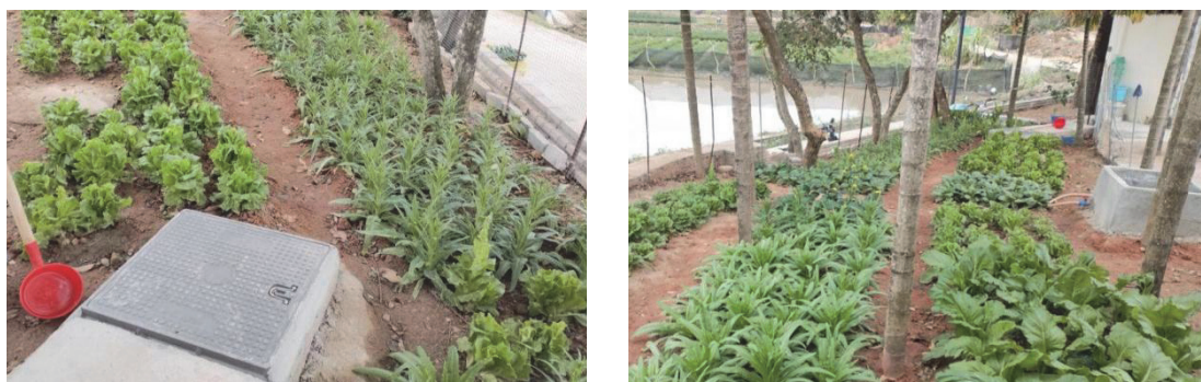
图 7-1 黑水无害化处理和灰水预处理后资源化利用实景图
