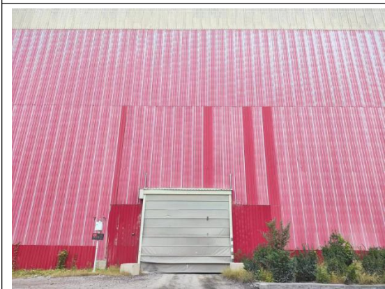
石灰石预均化堆棚
