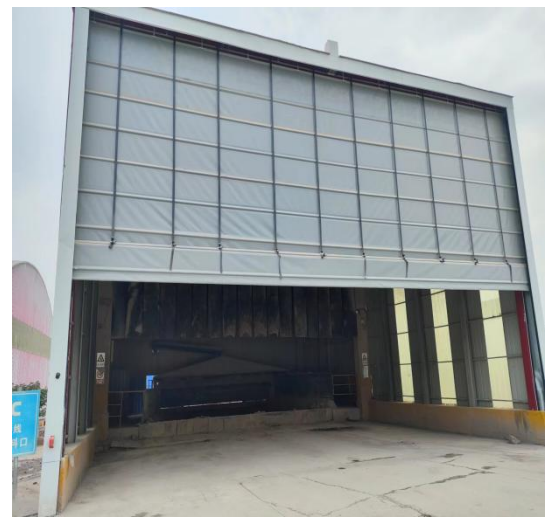
5000t 石灰石下料口设置自动门
