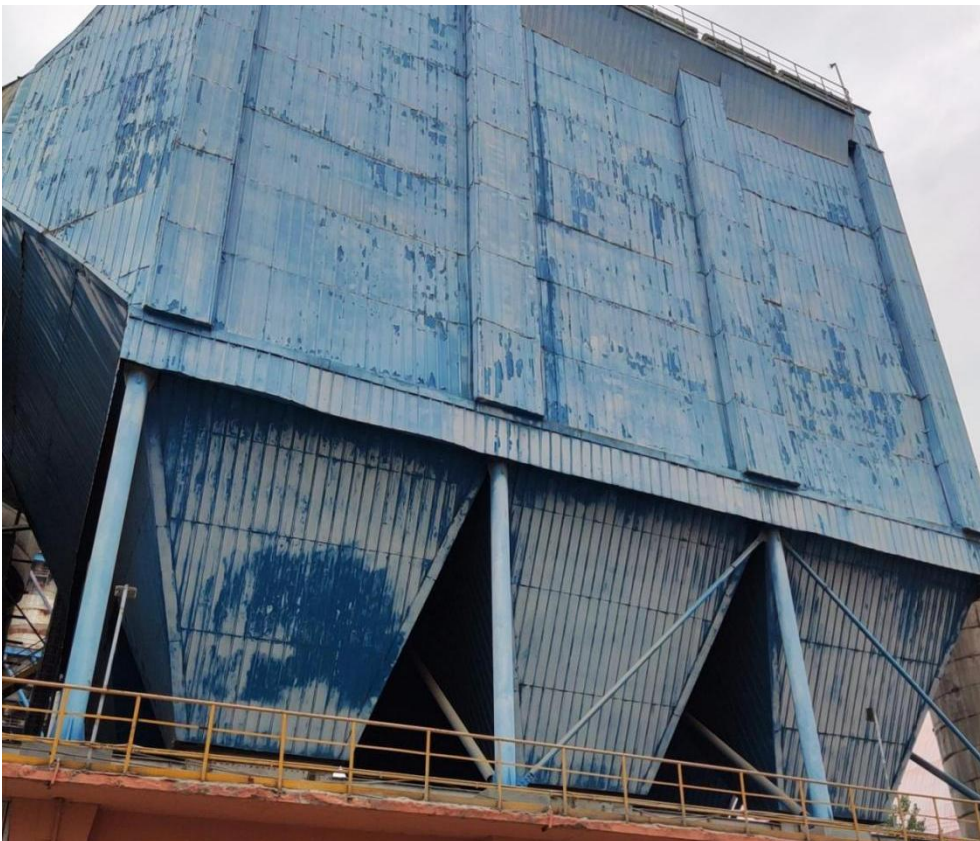
3#水泥窑窑头除尘器
