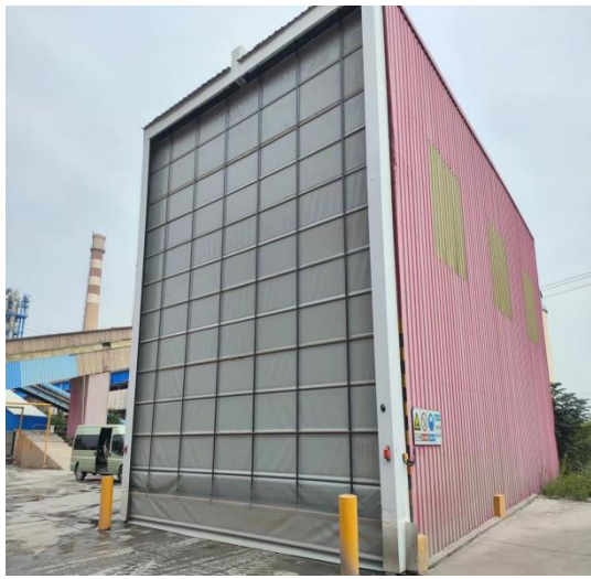
砂岩下料口设置自动门
