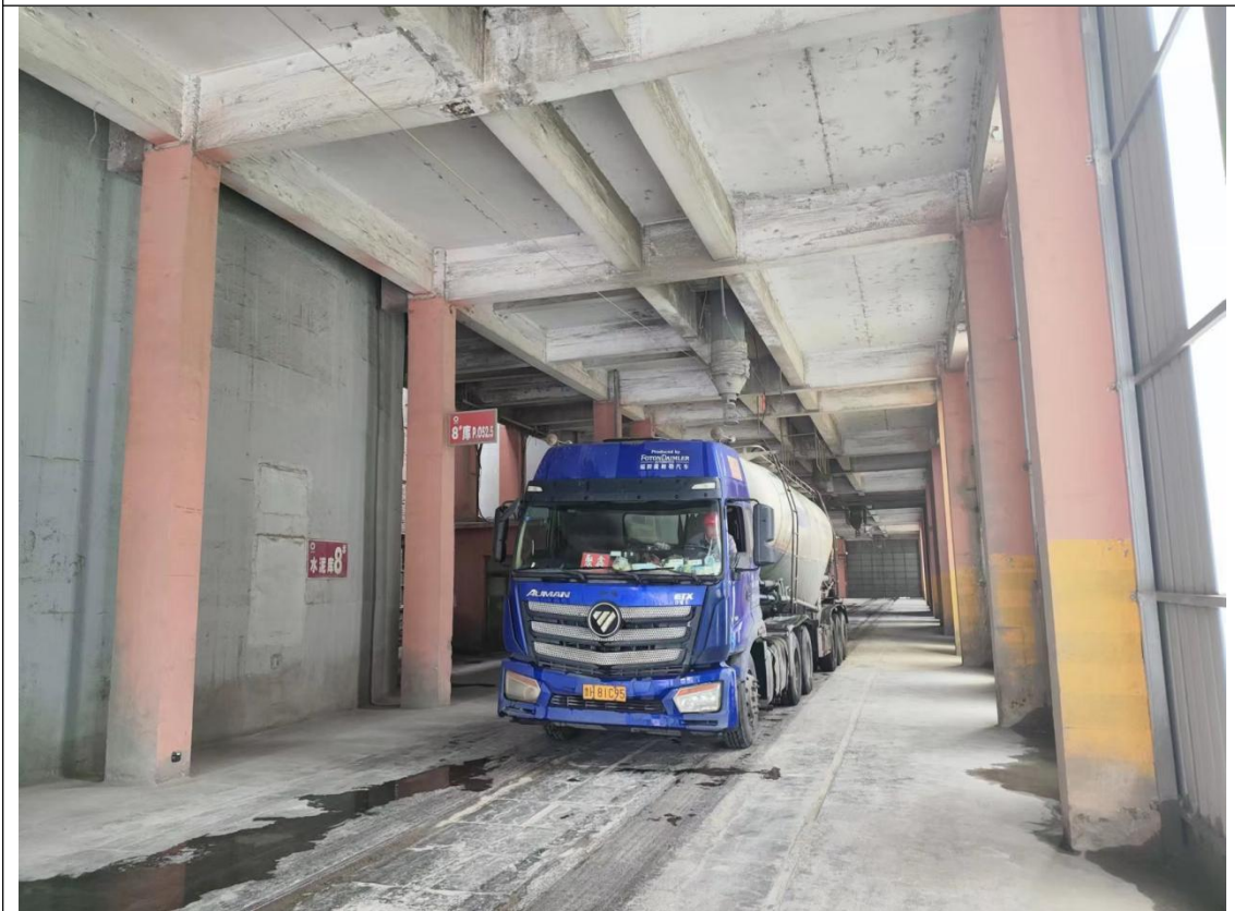
封闭水泥散装装车通道
