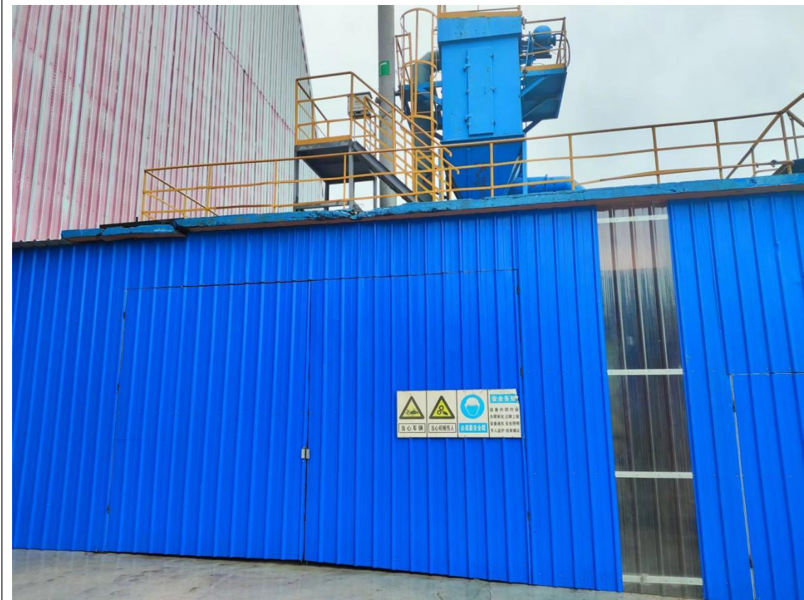
石灰石取料皮带机头落料至石灰石斜皮带转运站封闭
