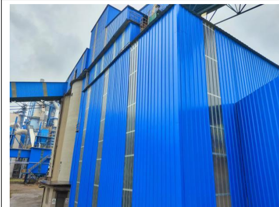
配料库底封闭
