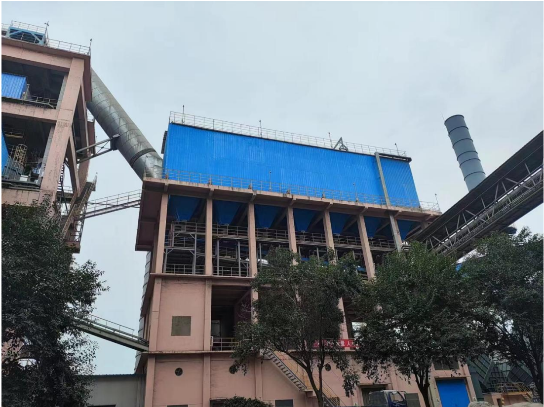
水泥立磨磨尾除尘器
