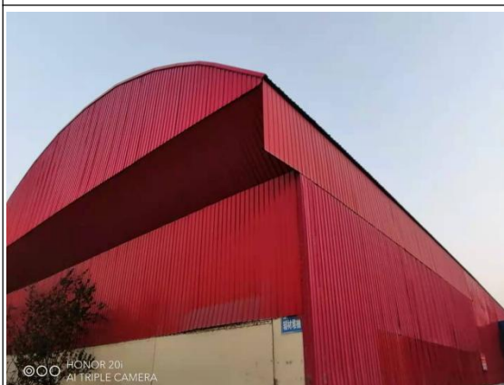
辅助原料预均化堆棚：已完成封闭
