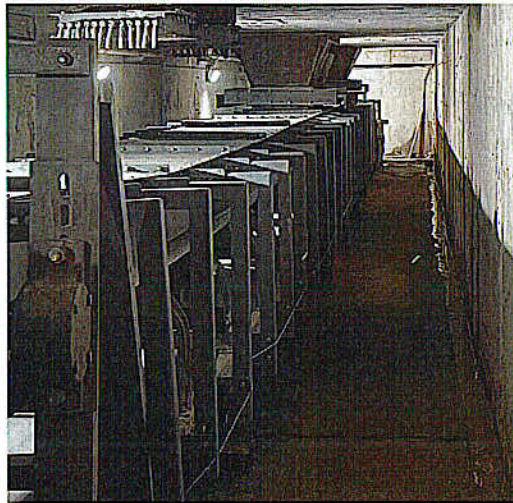
1#、2#石灰石下料口受料皮带及通廊
