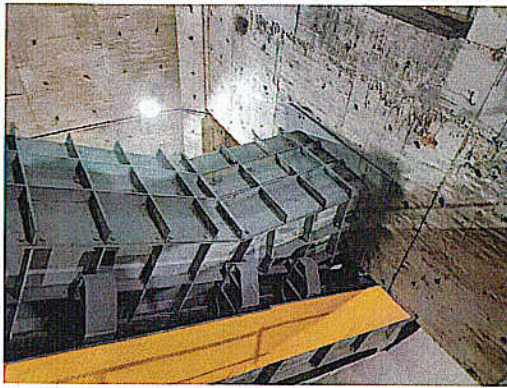
硅粉污泥下料口至板式喂料机
