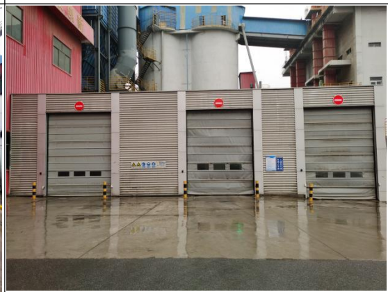
水泥散装发运车间
