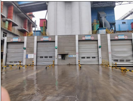
水泥散装发运车间
