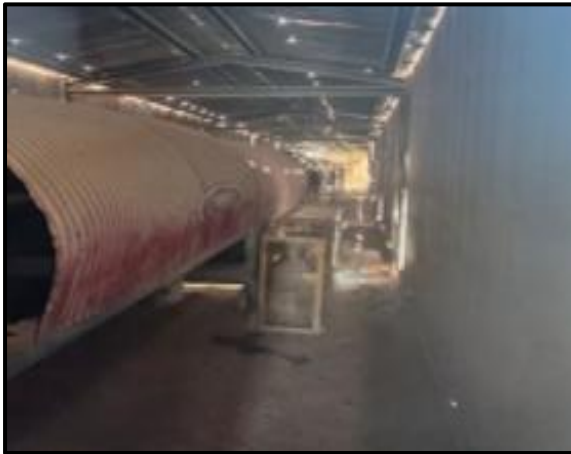
皮带通廊封闭
