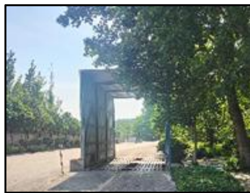
大门出口洗车平台
