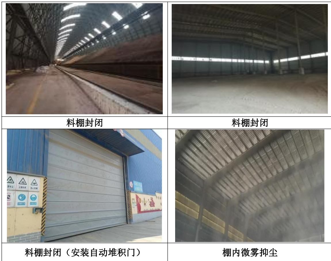
图 6 物料储存封闭情况
