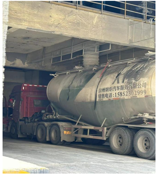
带抽风口的散装卸料装置
