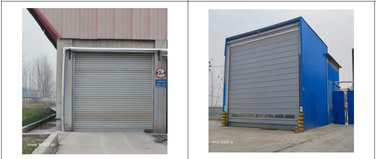
石灰石均化堆棚
