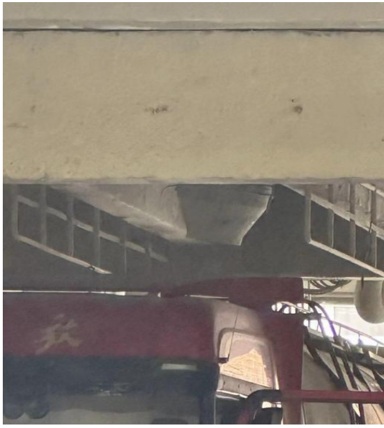
带抽风口的散装卸料装置
