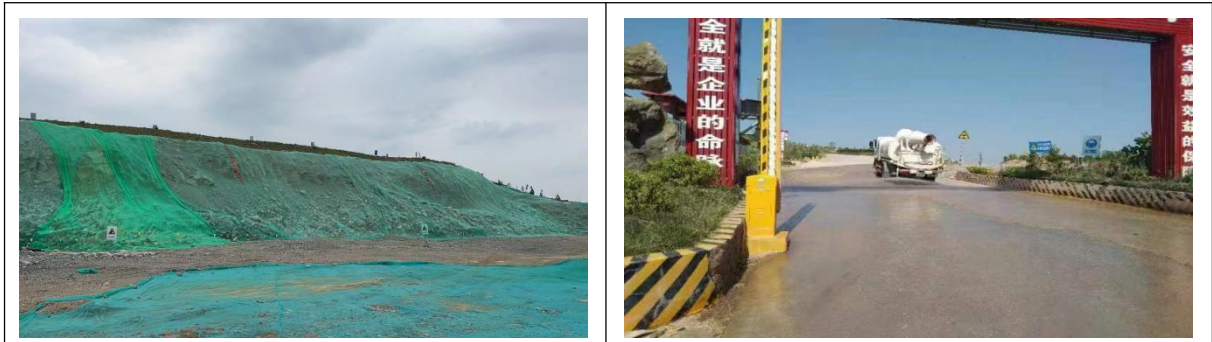
运矿道路硬化及定期洒水
