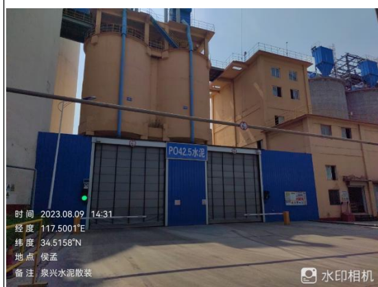
水泥散装发运车间
