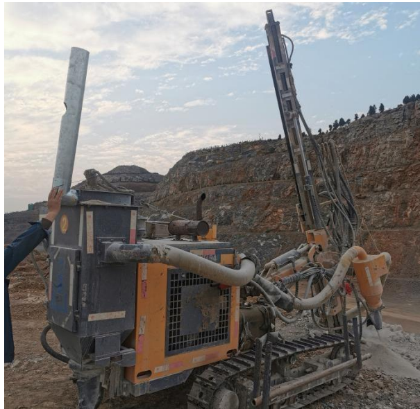
图 2.1-1 矿山潜孔钻机除尘整改完成情况
