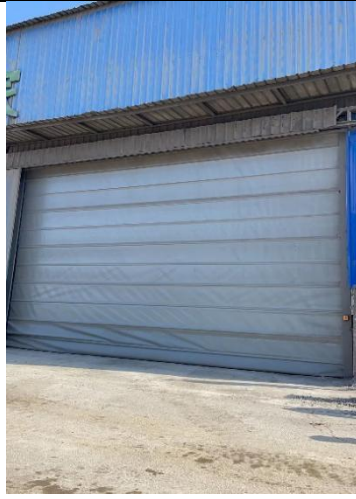
料棚出入口安装自动门
