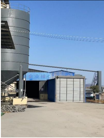
袋装车间出入口安装自动门
