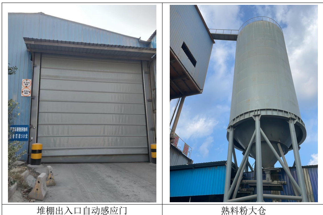
图 3.3-1 物料储存环节现场照片
